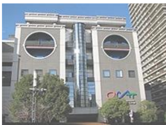
大阪シティエア ターミナルビル (OCAT) 4階
